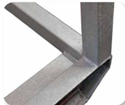
Гальванической покрытие рамы
