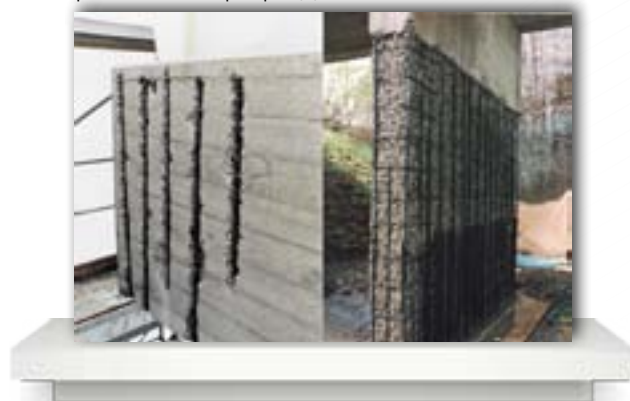
Санация и штрибирование бетона
