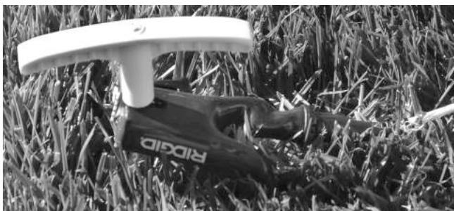
Рис. 7 – присоединение провода к заземляющему штырю
