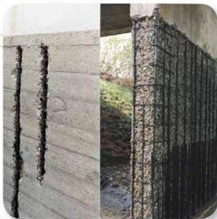
Санация и штробирование бетона
