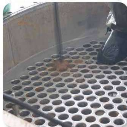
Очистка теплообменных аппаратов
