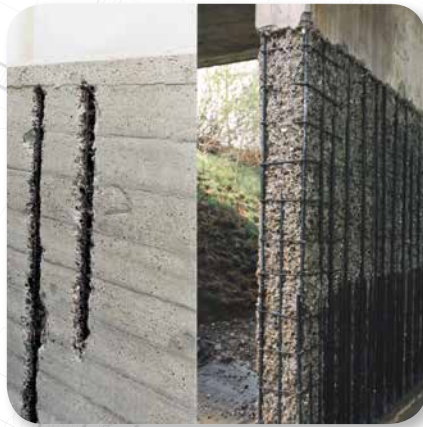
Санация и штробирование бетона
